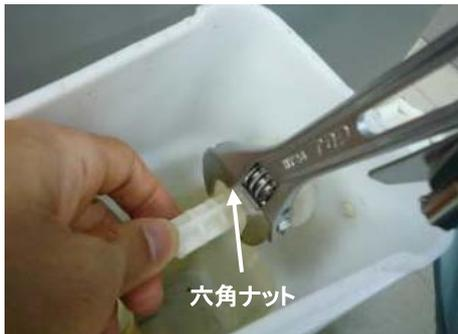
注意: 強く締めすぎると破損する
