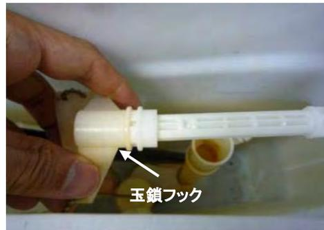
注意: 強く締めすぎると破損する
