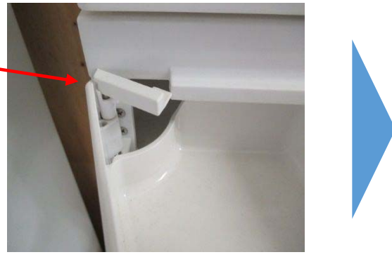
下に押しながら手前に引くとロックが外れる この状態になると上に引き抜く
