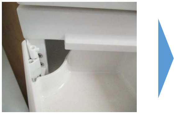
トレイを斜め下に引き抜くと外れる
